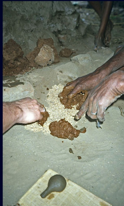
Reisspreu, Tonerde und Kuhdung werden vermisch
